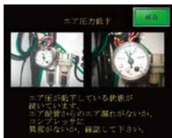
▲異常時確認画面(エア圧異常)
